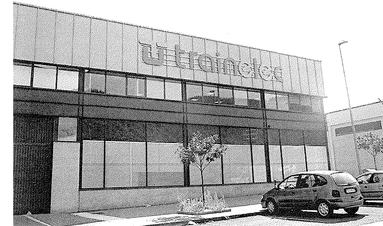
A pesar de ser una empresa joven, Trainelec afronta importantes proyectos como los equipos de tracción para el Tranvía de Vitoria
