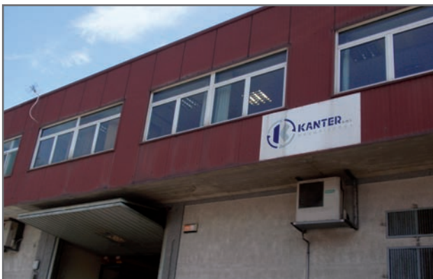
▲ Vista parcial de la fachada de la empresa de mecanizados de precisión Kanter, situada en el polígono Ugaldetxo de la localidad guipuzcoana de Oiartzun
