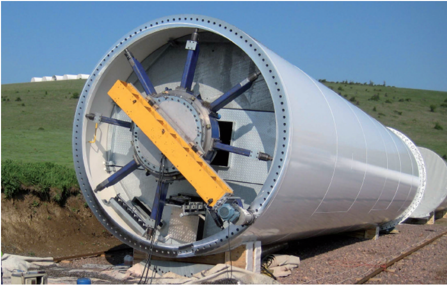
■ Mecanizado in situ de torre eólica
